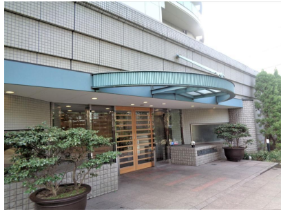
エントランス エントランスアプローチ
